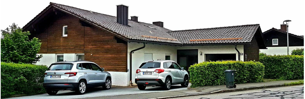
Außenansicht, Eingangsbereich, Garage
