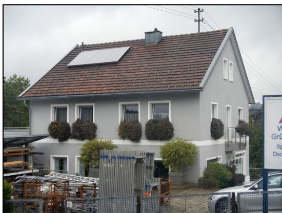
Abbildung 37: Wohnhaus "Zupp. Str. 9" (IO 37)
