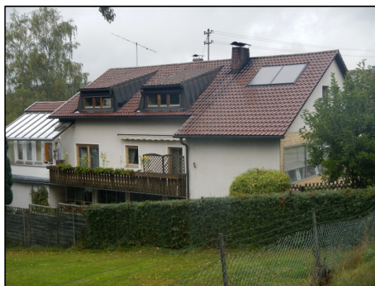
Abbildung 38: Wohnhaus "Zupp. Str. 7" (IO 38)
