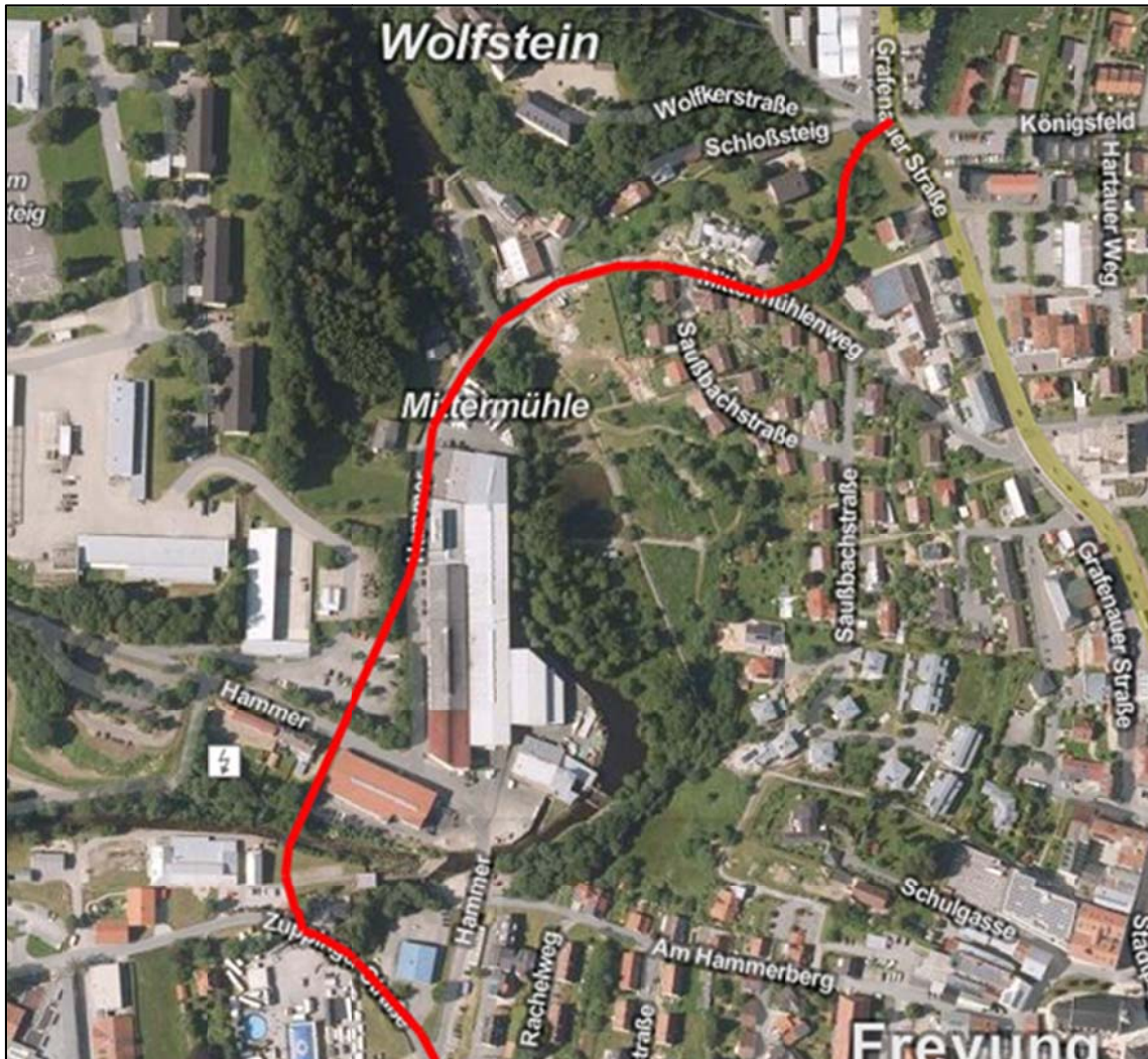
Abbildung 49: Nördlicher Bereich der Straßenbaumaßnahme
