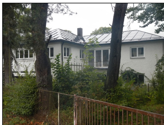
Abbildung 26: Wohnhaus "Zupp. Str. 26" (IO 24)
