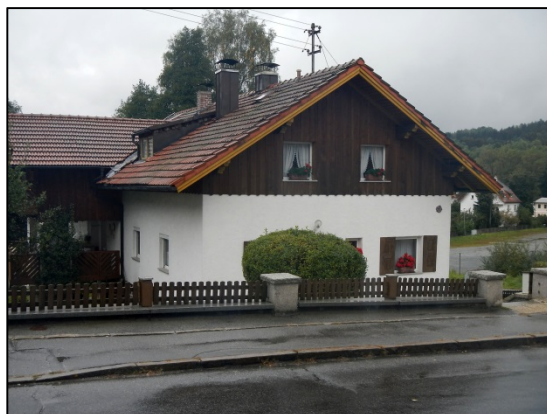
Abbildung 34: Wohnhaus "Zupp. Str. 15" (IO 34)
