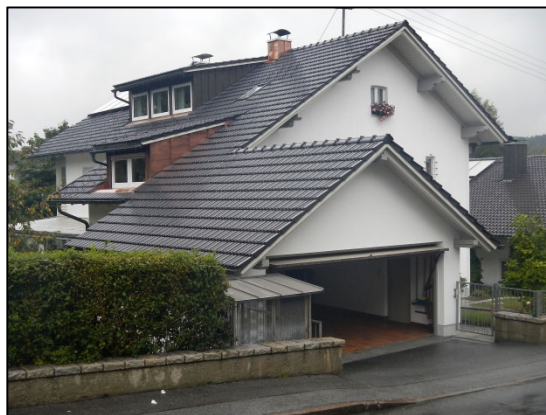
Abbildung 36: Wohnhaus "Zupp. Str. 11" (IO 36)
