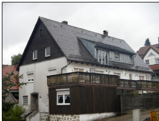
Abbildung 30: Wohnhaus "Zupp. Str. 20" (IO 28)
