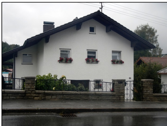
Abbildung 35: Wohnhaus "Zupp. Str. 13" (IO 35)
