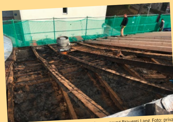
Dacherneuerung Brauerei Lang, Foto: privat
