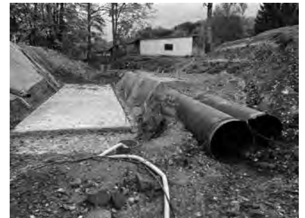
Baustelle Rohre und Bodenplatte: Durch die beiden Rohre fließt derzeit der Grillabach. Links auf der Bodenplatte wird der neue Durchlass platziert. Rechts im Hang sind an den dunkleren Schichten die beiden Vorgängerbrücken erkennbar.
