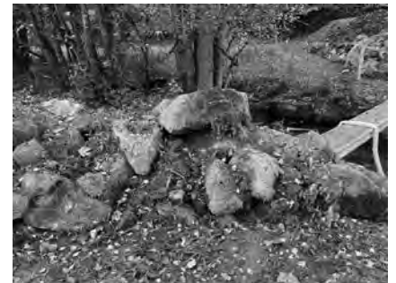
Steine aus dem Bachbett: Das Material, das wegen der Baustelle weichen musste, wird wieder unter der Brücke sowie an der Uferbefestigung eingebracht. (Fotos: Lang)
