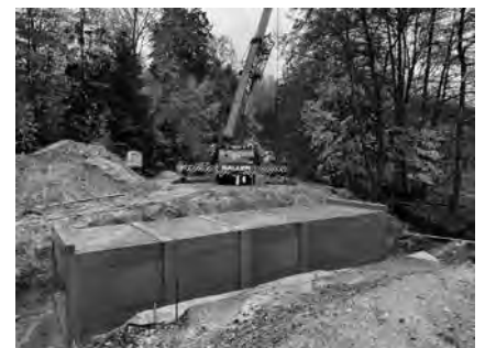
Anlieferung Rahmendurchlass: Am Montag wurden die Fertigmodule des Rahmendurchlasses angeliefert und platziert. (Foto: Ilg)
